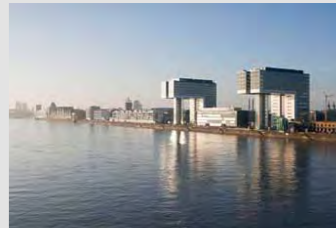
Kranhaus Mitte, Cologne, Germany
